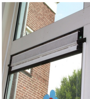
Figuur 2: Ventilatierooster (links), klepramen voor toevoer ventilatielucht (midden), afzuiging ventilatielucht in sanitaire ruimten, keuken, bergingen en inpandige ruimten (rechts) - bron: W/E adviseurs
