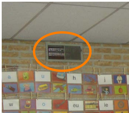
Figuur 5: Ventilatieroosters tussen verblijfsruimte en gang, in de muur (links) en in het raam (rechts) - bron: W/E adviseurs
