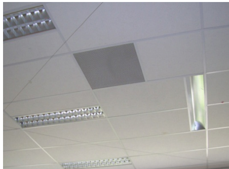
Figuur 4: Verschillende typen afzuigpunten voor ventilatielucht - bron: W/E adviseurs
