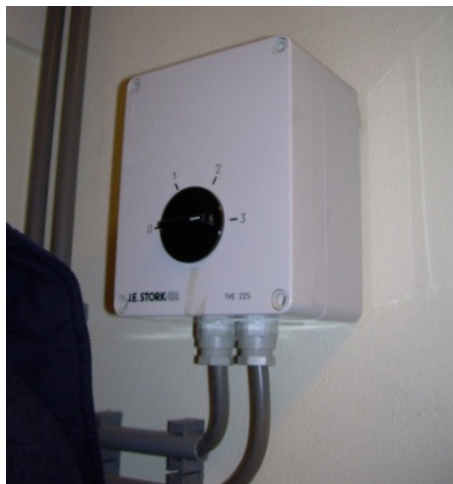
Figuur 6: Driestandschakelaar van een ventilatiesysteem - bron: W/E adviseurs
